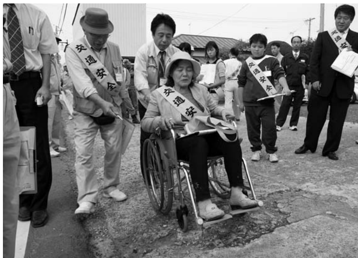
段差がある歩道を実際に車いすに乗って点検する参加者
