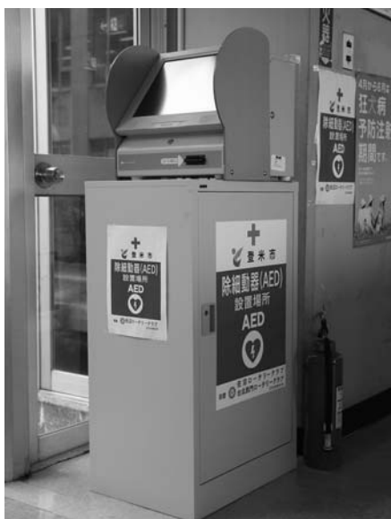
▶市役所迫庁舎に設置されたAED
