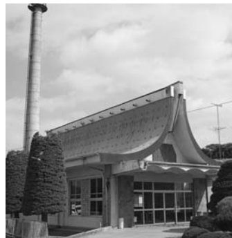
老朽化が進んでいる火葬場
