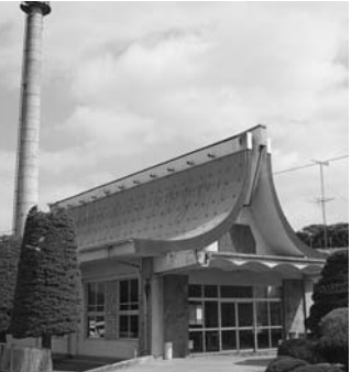
老朽化が進んでいる火葬場
