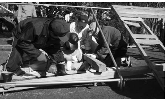
のこぎりやボールを使って屋根を壊し救出しました
