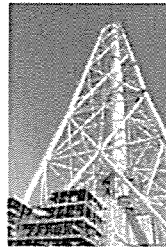
主排気筒の根元には防護板が設置される(建設中)
