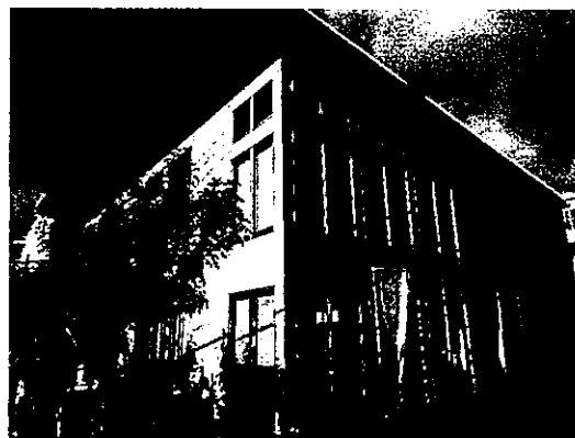
経営体で運営しているレストラン
